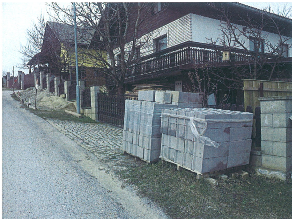
Krivi vrh – odložen material ob cesti in zidana ograja v varovalnem pasu
