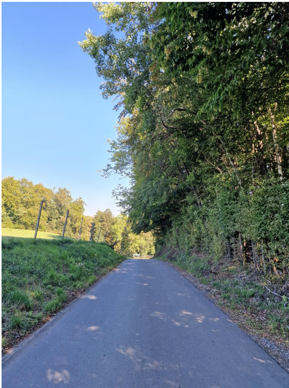
Fotografija 6 – primer opustitve del odstranitve vej dreves v svetlem profilu ceste
