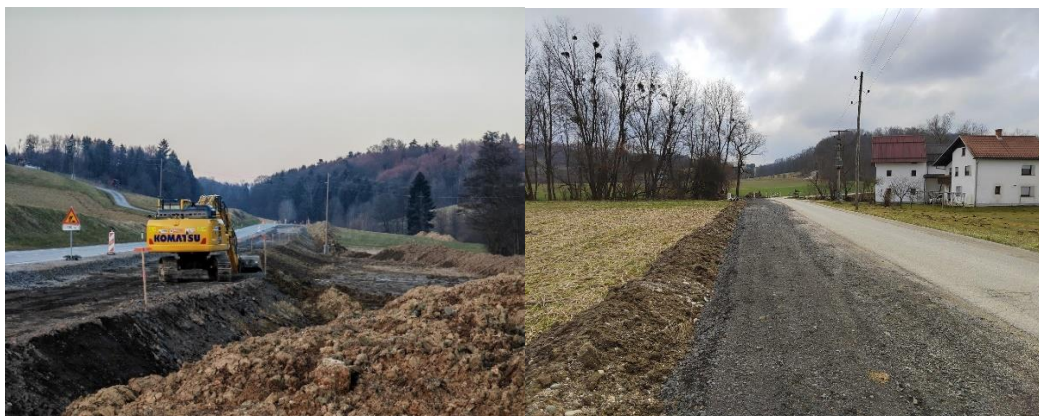
Slika 9: Izgradnja kolesarskih stez
