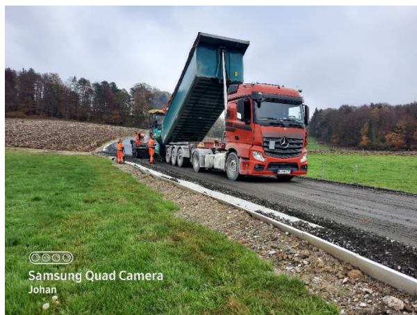
Slika 11: Asfaltiranje občinskih cest
