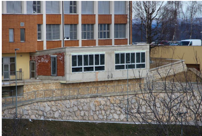
Slika 8: Izgradnja prizidka vrtca
