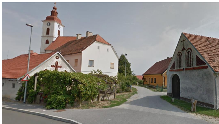
Slika 9: Stavbe okoli osrednje dominante s pretežno ohranjenimi značilnostmi avtohtonega stavbarstva
