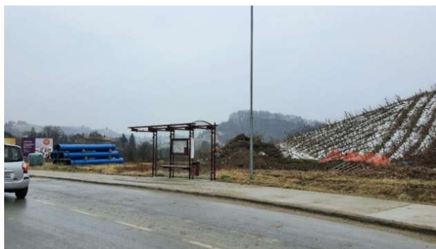
Slika 18: Gradbena dela na območju Košaki
