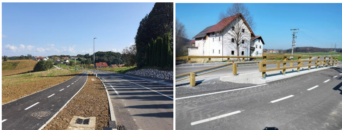
Slika 9: Izgradnja kolesarskih cest in mosta čez reko Ščavnica
