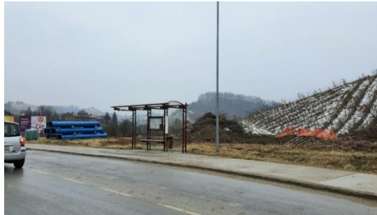
Slika 10: Polaganje novega cevovoda v Košakih
