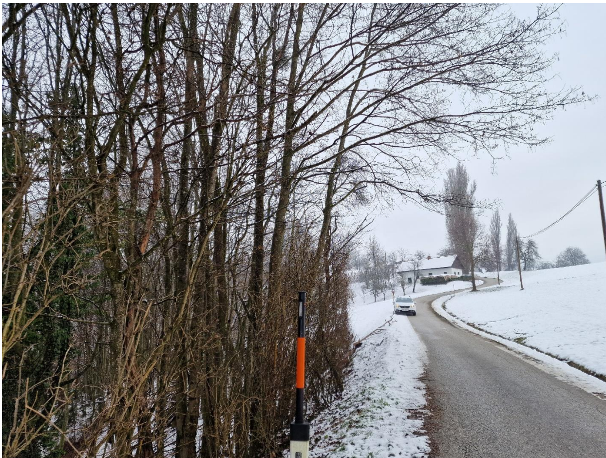
Fotografija 2 – primer nevarnih dreves ob cesti
