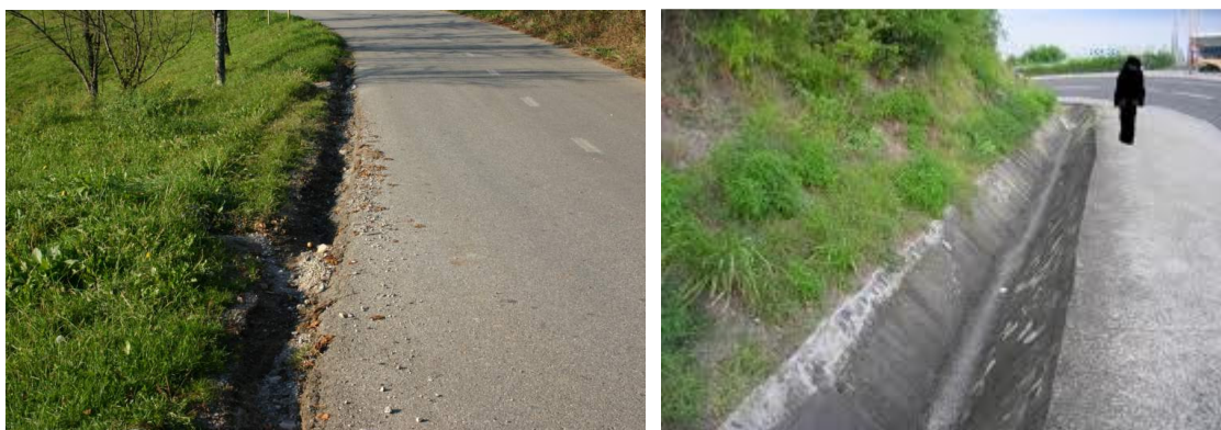
Slika 21: Ureditev odvodnjavanja in bankin bo izboljšala varnost v prometu.
